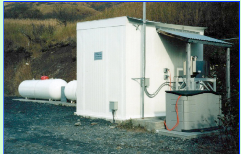
Thermoelectric generator KDAK (Kodiak, Alaska)
