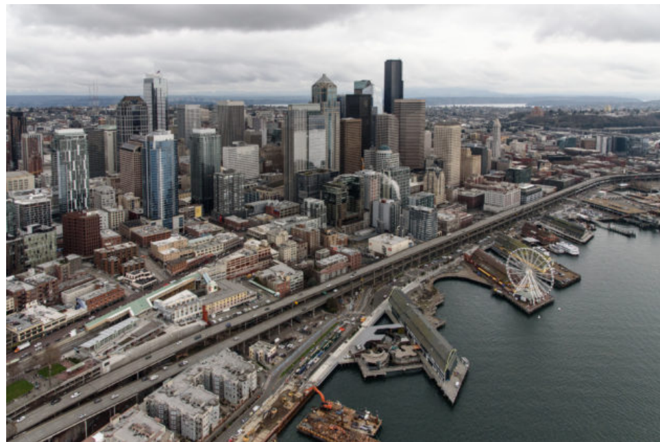
Viaducto Alaskan Way
