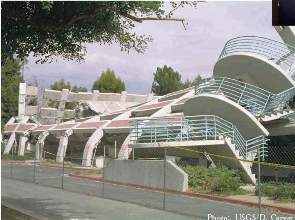
La Universidad Estatal de California, Northridge sufrió daños muy graves, sobre todo el colapso de las estructuras de estacionamiento.
