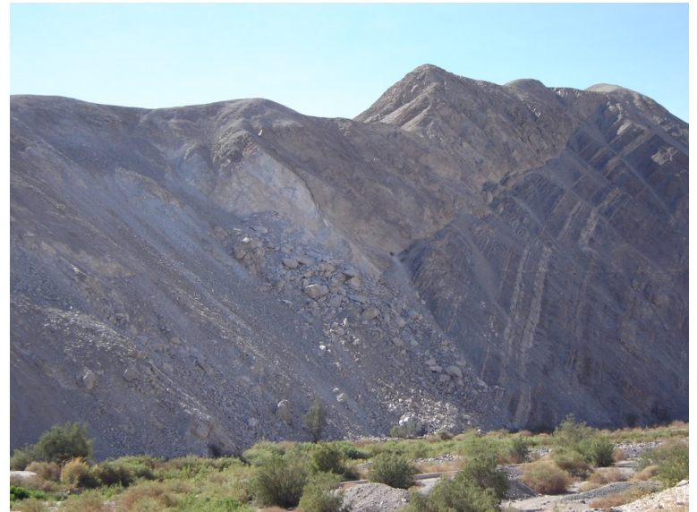
Caída de bloques en Quebrada Tarapacá, terremoto del 13/06/2005
