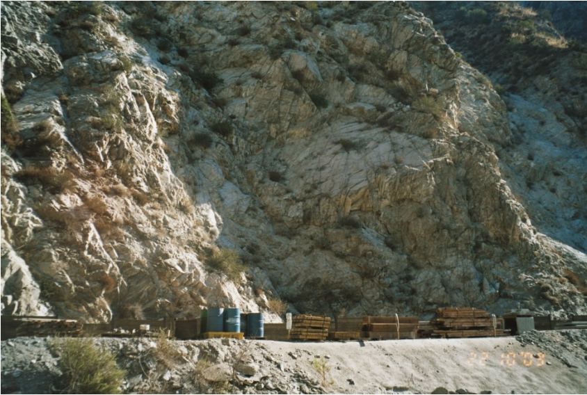
Deslizamiento de roca en bloque de tipo plano, Cañón de Pacoima, California, terremoto de Northridge, 1994.
